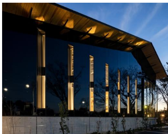
〈オフセットサイディング 施工事例〉
