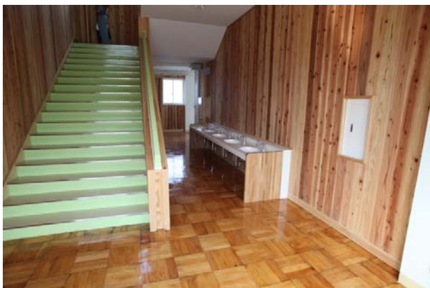
改修後の廊下と階段
