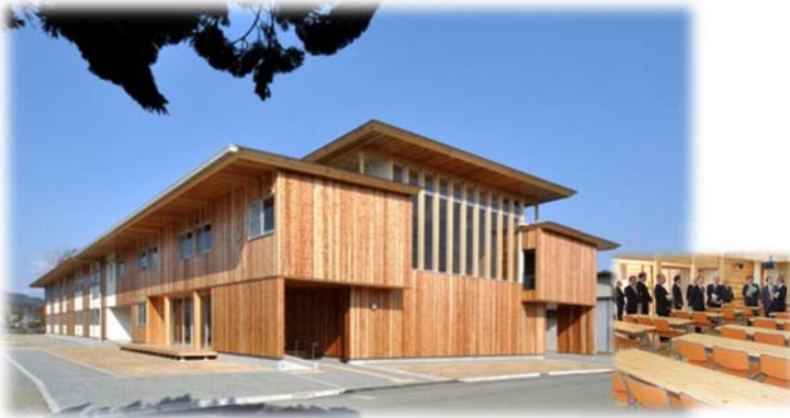
岡山県: 農業大学校研修交流ホール
