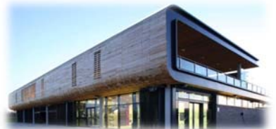
カヌー競技場(内外壁、床、天井に使用)
