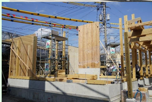
CLTパネル設置状況（平成30年3月）
