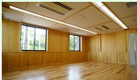
会議室（壁の一部はCLTパネルあらわし）
