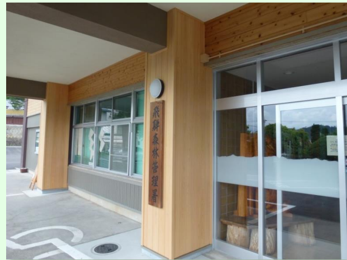
農林水産省 飛騨森林管理署庁舎(柱、天井、壁)
